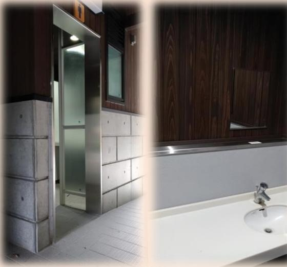
県指定史跡『掛橋坂』にある公衆トイレの入口三方枠と面台の製作です。ステンレスの板を曲げ加工して設計寸法に製作します。このような製品は既製品でありそうですが、実はオーダーメイドでの製作が多いです。
